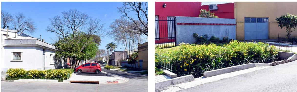
Ilustración 2: Jardín de lluvia instalado por calle Guaviyú (izquierda); Jardín de lluvia instalado por Calle Antonio Machado (derecha). Municipio C.
